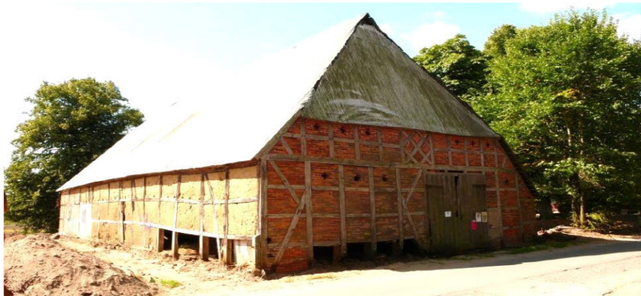
Scheune des Hofes-Nr. VIII von Hans Joachim Schleuss. Man sieht sehr gut das Fachwerk und die Giebelwand in Ziegelausführung. Die Seitenwände sind in Lehmputz ausgeführt.
