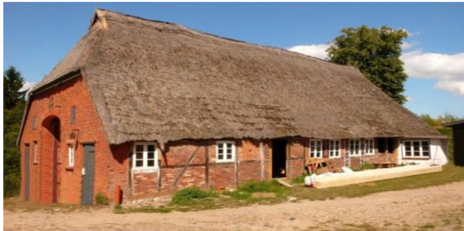
Wohnhaus (erbaut 1867), Hof-Nr. XIII vor der Renovierung (August 2013).
