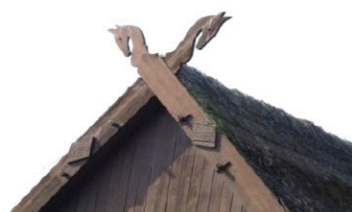
Pferdeköpfe als Giebelschmuck. In diesem Fall sind die Köpfe nach auswärts gedreht.
