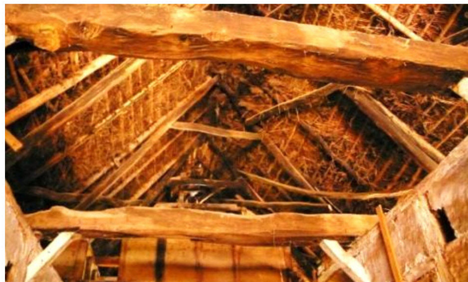
Blick in das Dachgebälk des Wohnhauses.
